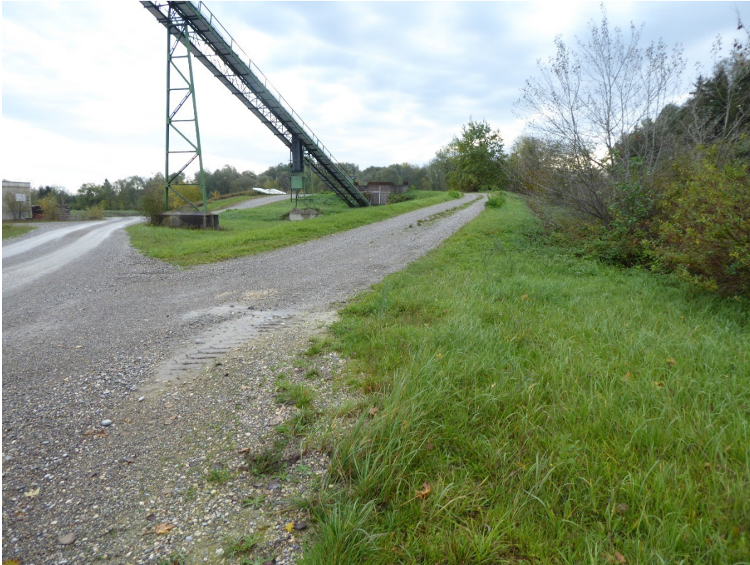
Abbildung 13: Förderanlage, die Grünflächen werden regelmäßig gemäht
