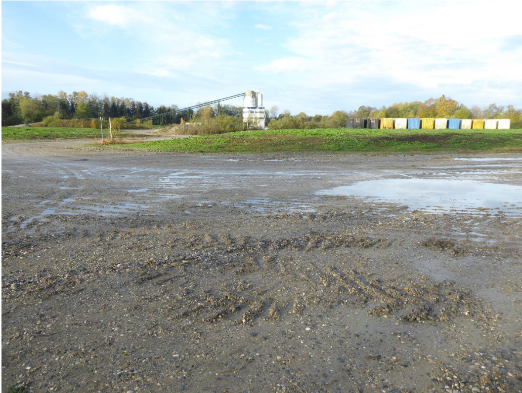
Abbildung 3: Blick von Osten über die Vorhabensfläche Richtung Westen. In der Bildmitte befinden sich ein flaches Humuslager, im Hintergrund die Förderanlage dazwischen im linken Bildrand der Containerlagerplatz
