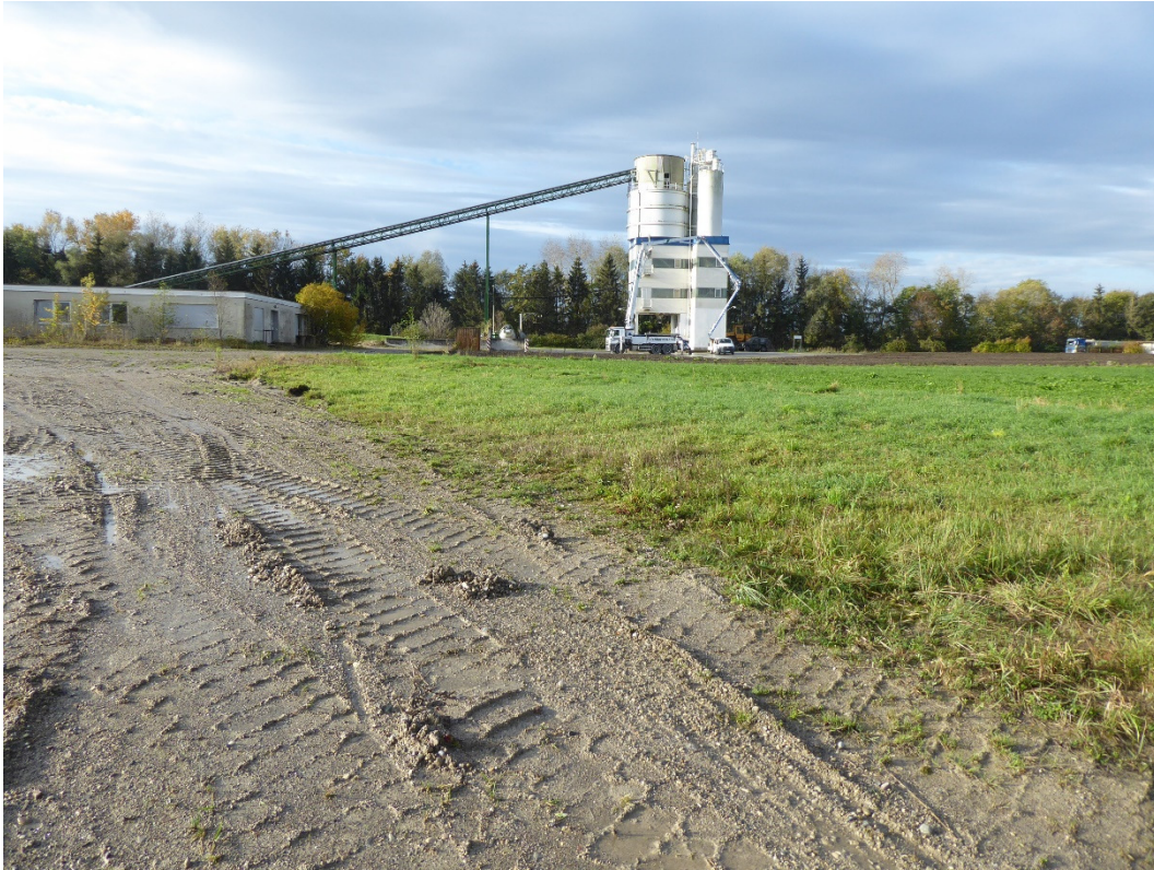
Abbildung 9: Blick von zentraler Position in Blickrichtung Südwesten. Im Bildvordergrund eine schon angesäte Grünlandfläche.. Im Hintergrund die Förderanlage und links das Büro- und Laborgebäude.
